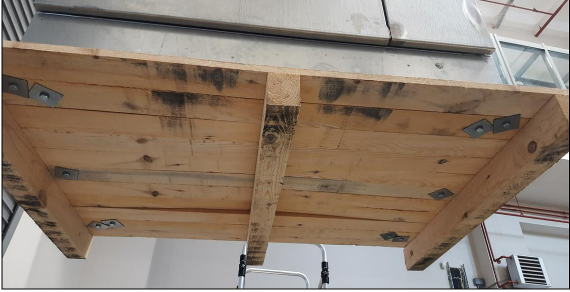
Resim 4. Palet Bağlantı Detayları
